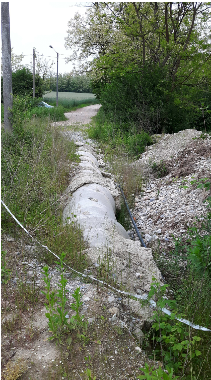
Figura 4: tubazione scoperta lungo Via dell'Abbazia
